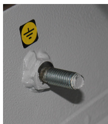
Рисунок 5. Болт заземления.
